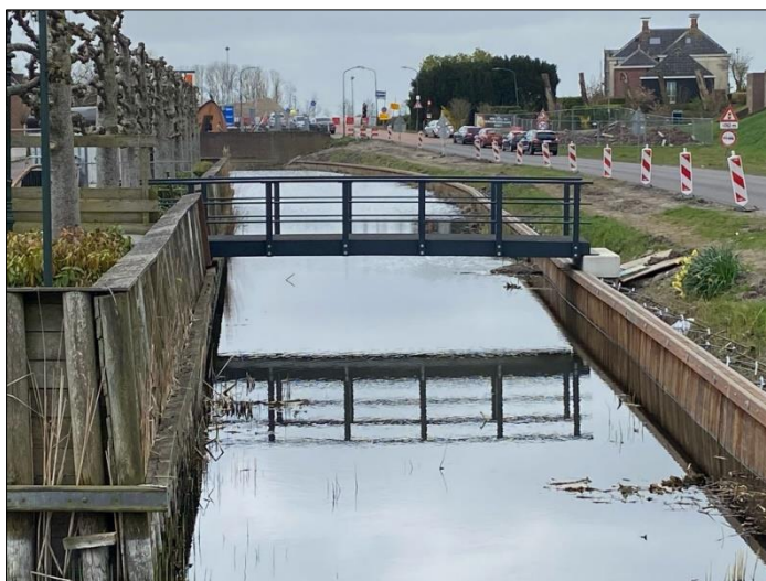
Nieuwe brug Spuistraat
